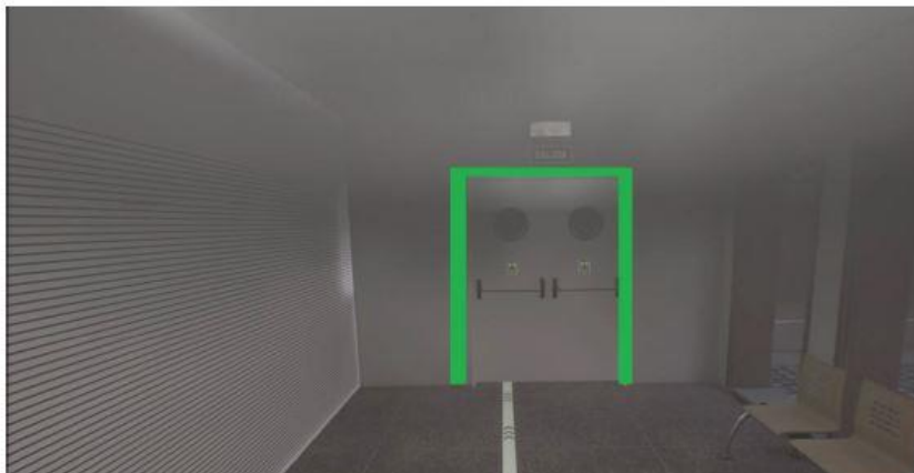
Itinerarios de evacuación en pavimento foto luminiscentes implementados en la zona de Consultas Externas
